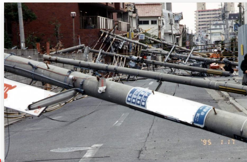
地震時の電柱倒壊（阪神淡路大震災）
