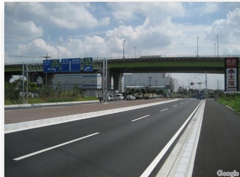
外環道付近完成区間（和光市）
