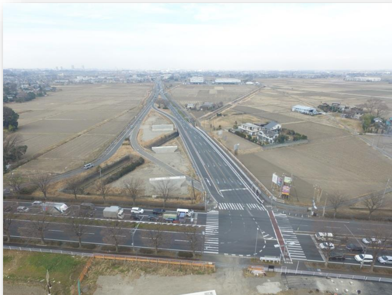
国道463号陸橋工事（富士見市）
